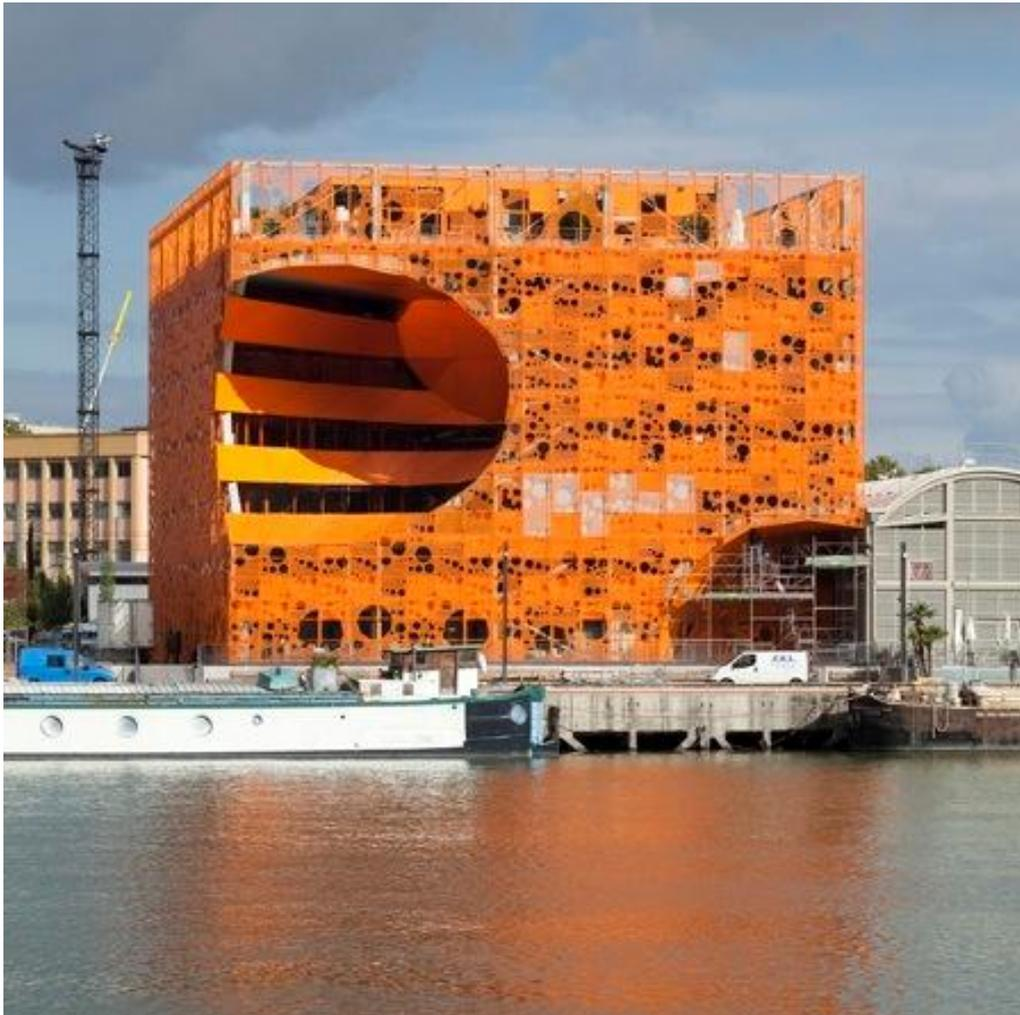
El gran edificio, un cuasi-cubo de 29 por 33 metros, dispone de una **superficie de 6.300m<sup>2</sup>** y su estructura de **5 plantas** está construida con pilares de hormigón. La fachada exterior, una piel metálica con aberturas aparentemente aleatorias y que se ha pintado en color naranja industrial, cubre una fachada interior de ventanas dispuestas según un diseño pixelado. **El conjunto produce un efecto visual de aguas en movimiento**, semblante al cauce del río.
