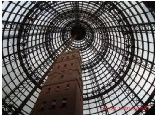
El con de vidre és la major estructura de vidre del seu tipus al món. The cone is 20 storeys high, weighs 490 tonnes and has 92 glass panes. El con és de 20 pisos d'altura, pesa 490 tones i té 92 panells de vidre. The glass panes are cleaned by a specially designed mechanical system. Els cristalls es netegen mitjançant un sistema especialment dissenyat mecànica.
