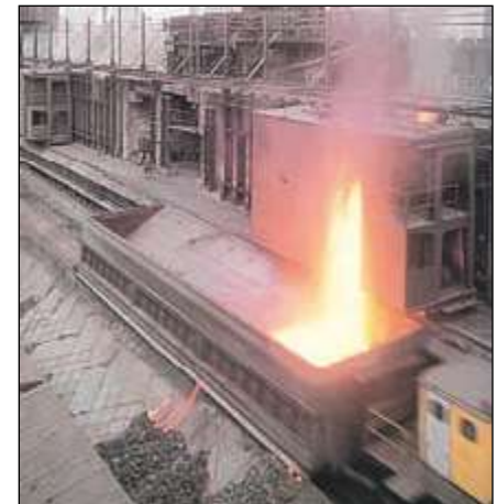
Baterías de coque.
