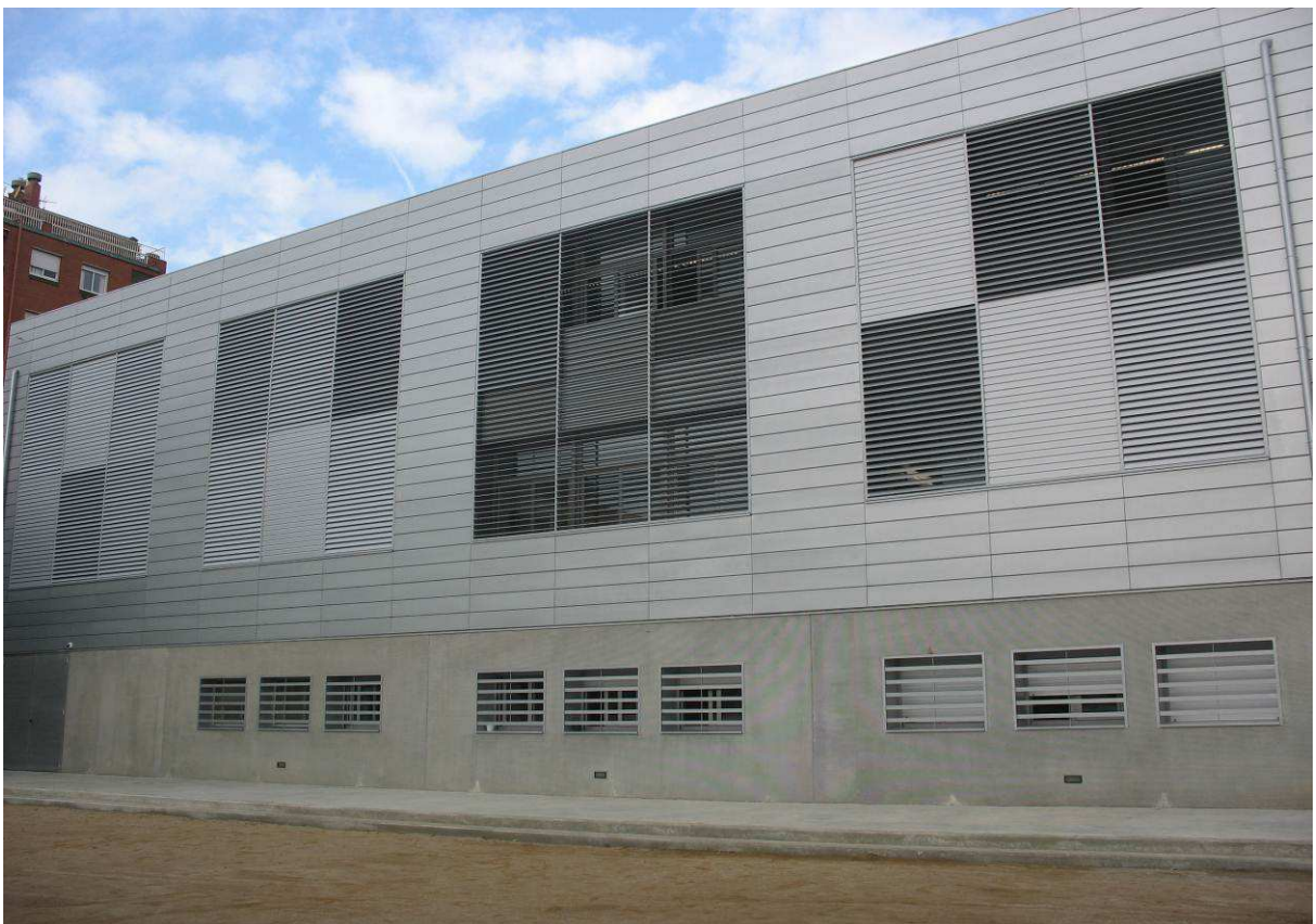
Panoràmica actual del nou edifici
