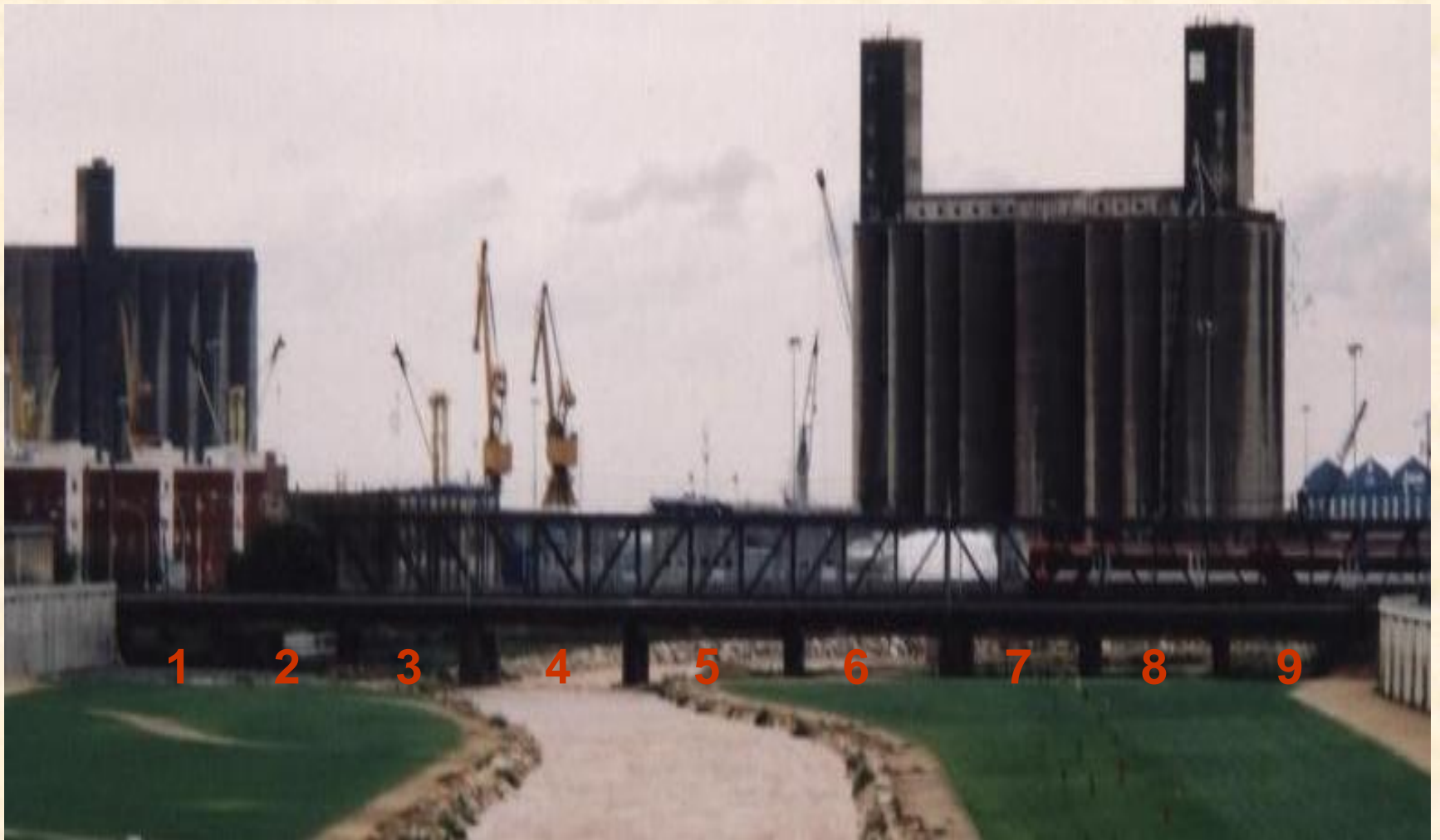
Zona B: Pont de la línia de ferrocarril Barcelona - Madrid.
