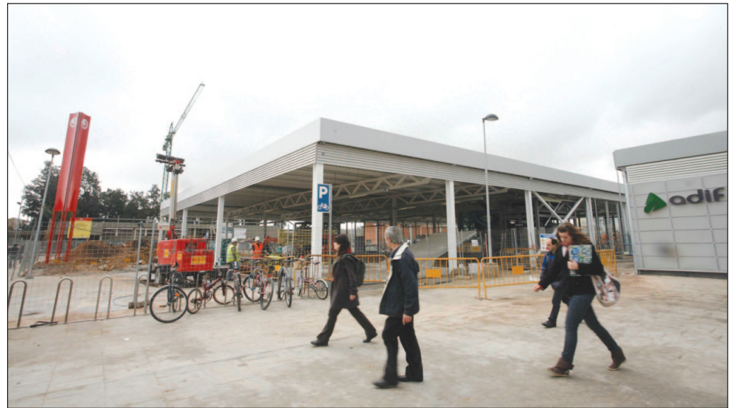
La estructura levantada hace unos meses, junto a la estación de Renfe, el miércoles
