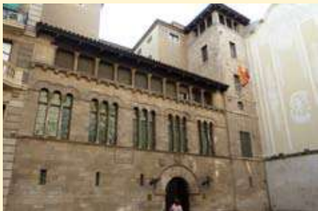
Façana de la Paeria
